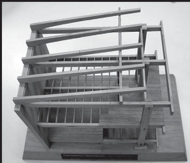
Figura 07: maquete de estrutura de edificação em madeira.
