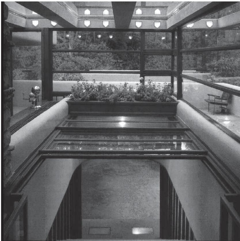
Figura 15 - Escada de acesso ao nível da água. A solução do ritmo das aberturas entre painéis com divisões verticais nas áreas de abrir e horizontais nas áreas fixas.
