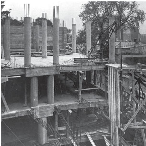
Figura 31 - 51-55 da Rua Raynouard, Paris, 1929-32. Obra do edifício, com destaque para as vigas de transição. (GARGIANI, 1994, p.100).
