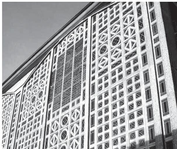
Figura 25 - Fachada lateral com os módulos de concreto e vidro, estruturados por grandes “montantes” verticais em concreto armado. (Disponível em <<http://www.structurae.de/photos/raincy03.jpg>> Acesso em 05 agosto 2003).
