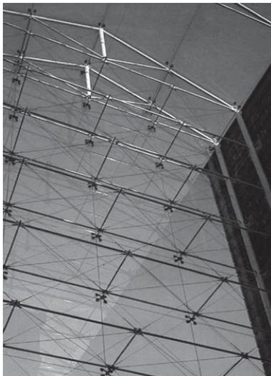
Figura 11 - A fachada suspensa.
